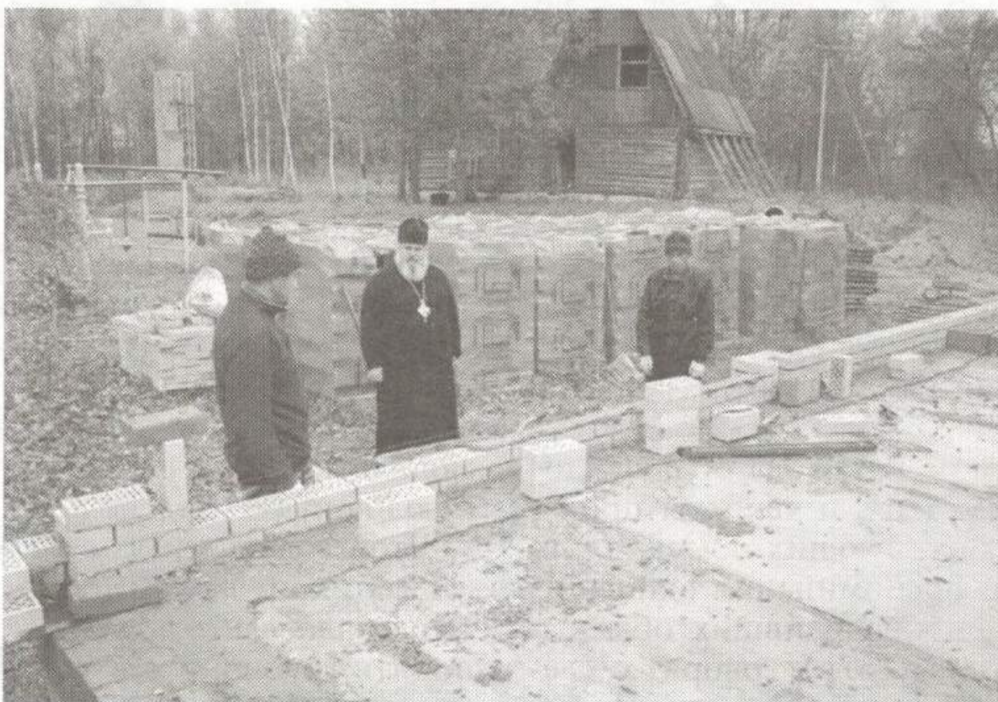
Начало строительства нового храма (2017 г.)
